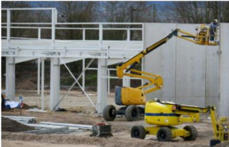
Plusieurs cellules commerciales sont en cours de construction dans la zone industrielle Sud. PHOTO DNA - Franck Delhomme
